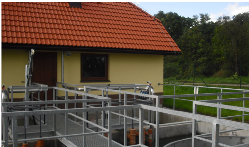
Obr.: Nově vybudovaná ČOV Dětenice
