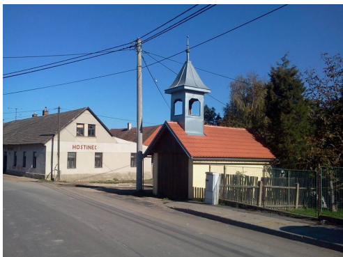
Obr.: Brodek, opravená zvonička
